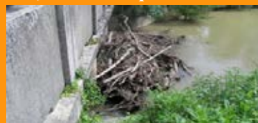
Accumulation d'embâcles sur les piles d'un pont : risque de rupture d'ouvrage et d'inondation.
