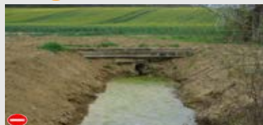
Passage busé non conforme et mal posé provoquant une rupture de l'écoulement.
