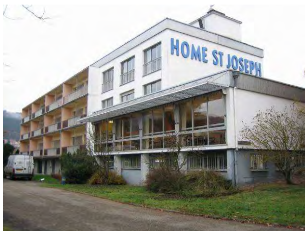
Bâtiment existant façade sud
