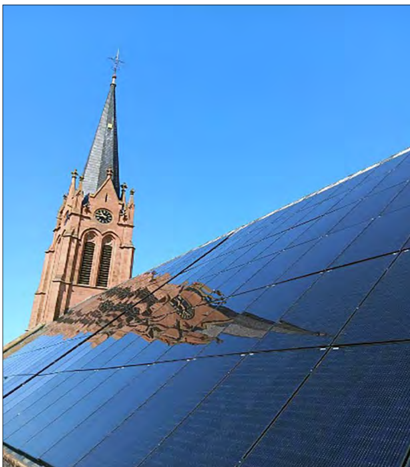
Installation de 67,2 kWc (ou 168 panneaux) sur l'Église de Steinbourg.
